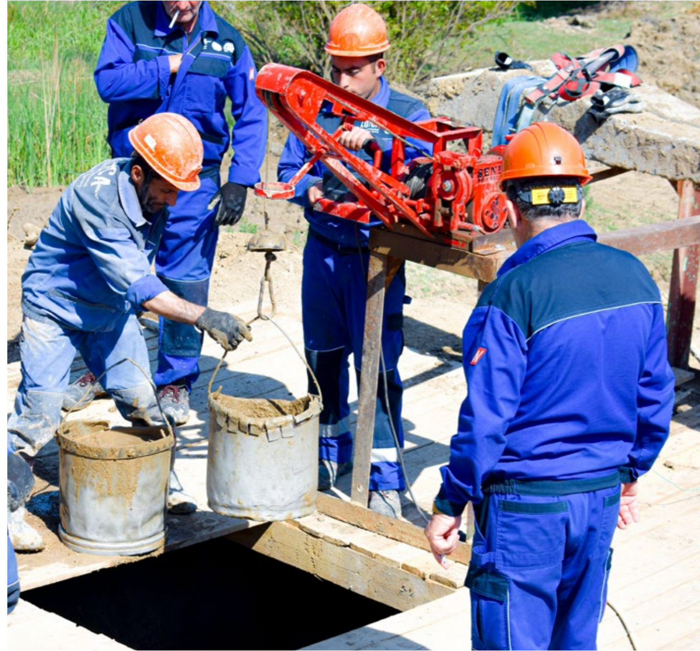
Ənənəvi, dayanıqlı su təchizatı sistemləri olan qədim kəhrizlərdə bərpa işləri genişlənilir. Beynəlxalq Miqrasiya Təşkilatı /2022
