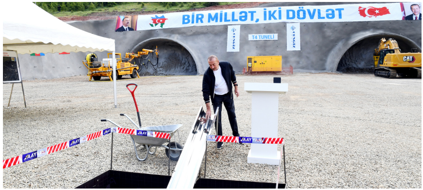
Əhmədbəyli-Füzuli-Şuşa avtomobil yolunun Daşaltı kəndinin ərazisindən keçən hissəsində tunelin təməlinin qoyulması
