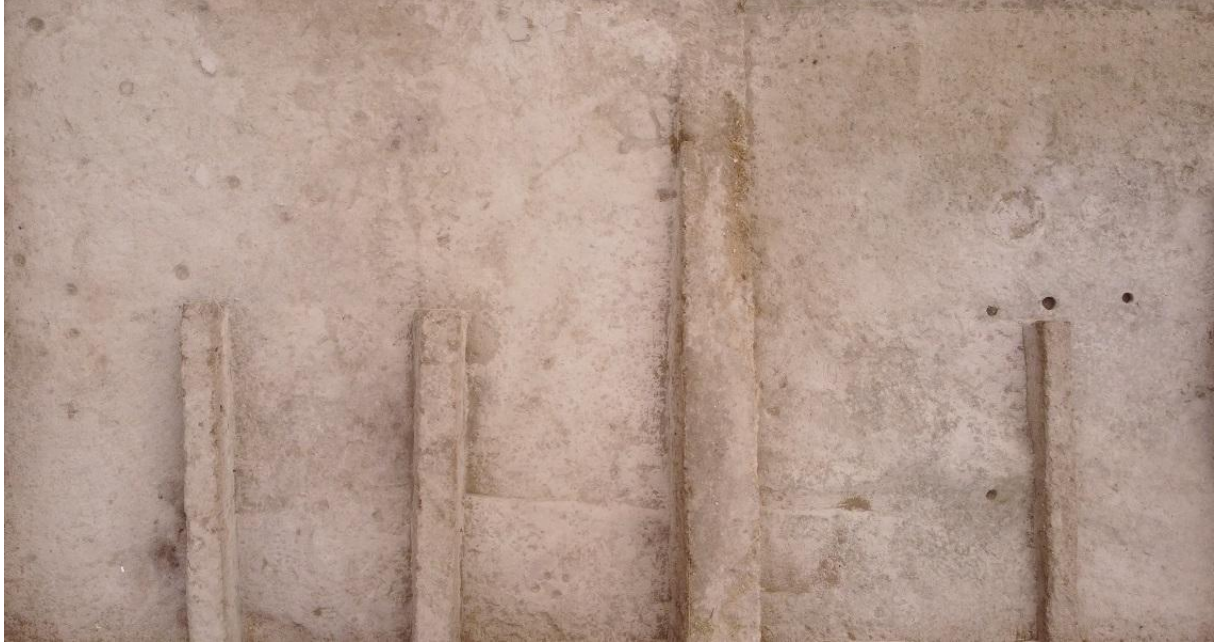
Şəkil / Figure 4. Qazıntı sahəsinin dron görüntüsü / Drone view of the excavation area.
