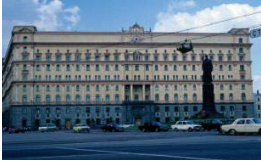
Şəkil 2.5. Dzerjinski meydanında yerləşən DTK-nın mərkəzi aparatı
